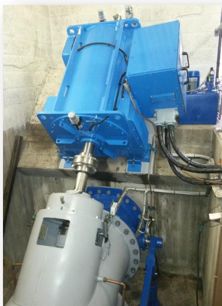
Ny generator och turbin åter i drift
